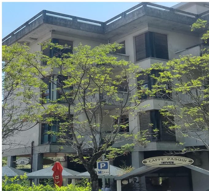
Centro Direzionale e Commerciale Viale Roma
