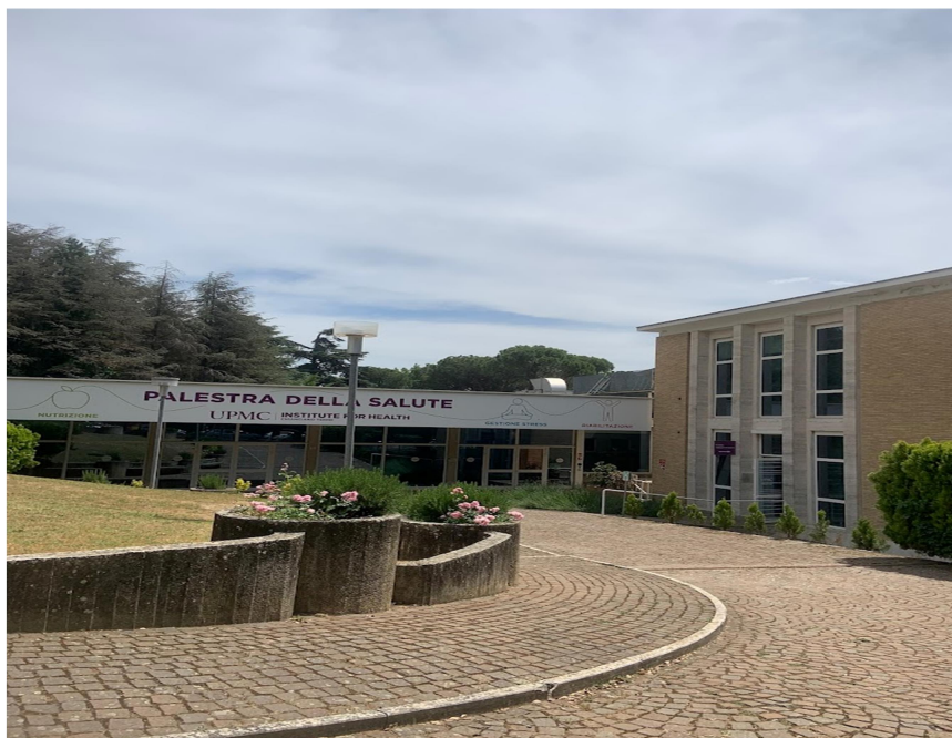
Direzione Sanitaria Viale Roma corpo centrale e area ex UPMC Palestra della salute
